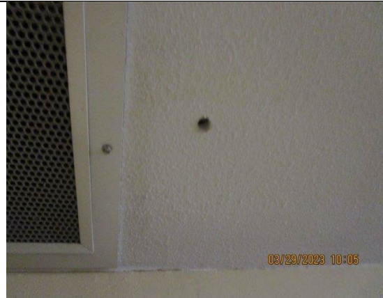
Heavy Orange Peel Drywall
