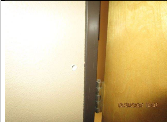
Light Orange Peel Drywall
